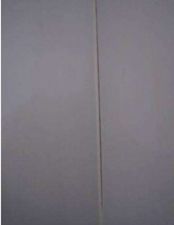
Silikonfuge löst sich bei Mittelwand zur Heckwand
